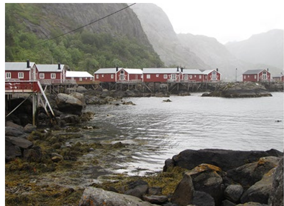
Figur 41 Rorbuer i Nusfjord på Skjæret. Her ligger dagens avløpsrenseanlegg som renser avløpsvann fra hele turistanlegget.
