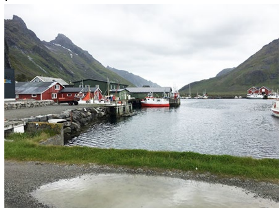
Figur 25 Havneanlegg mot sør..
