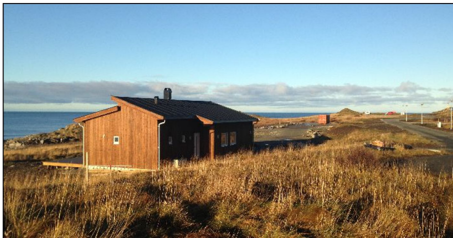
Fritidsbolig på Jusneset, Ramberg, ferdig høsten 2015.
