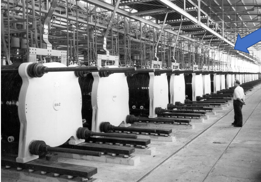
Den gamle hydrogenfabrikken (1949-1993) Produksjon: 65 tonn hydrogen per dag Ble brukt til å lage ammoniakk til produksjon av mineralgjødsel
