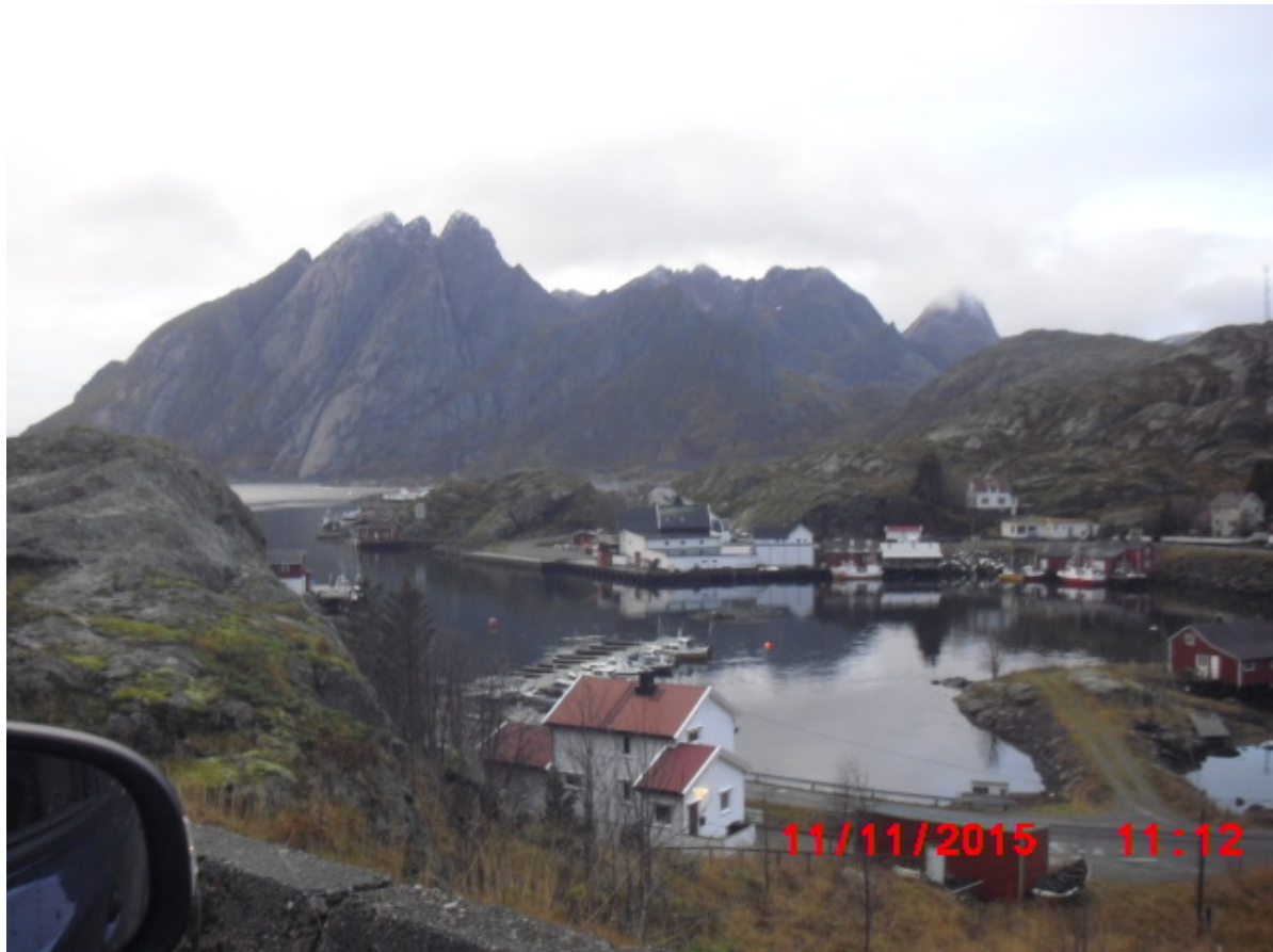
Sund. Bildet er tatt fra østre side av Sundvågen. Foto: Rambøll.
