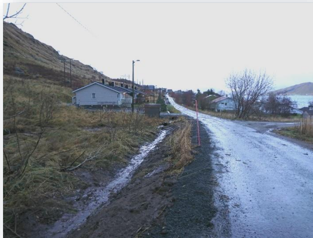
Figur23 Bilde av Solhøydgeveien på Napp: utdypping av grøfter
