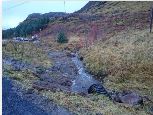
Figur 24 Bilde av Solhøydgeveien på Napp: utdypping av grøft
