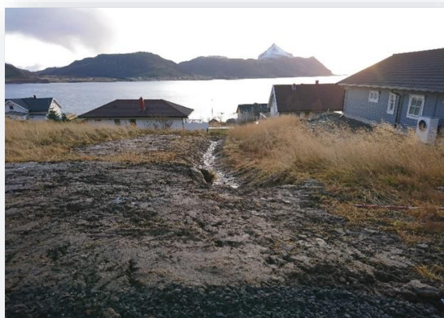
Figur 22 Bilde av Hauan på Napp: ny grøft
