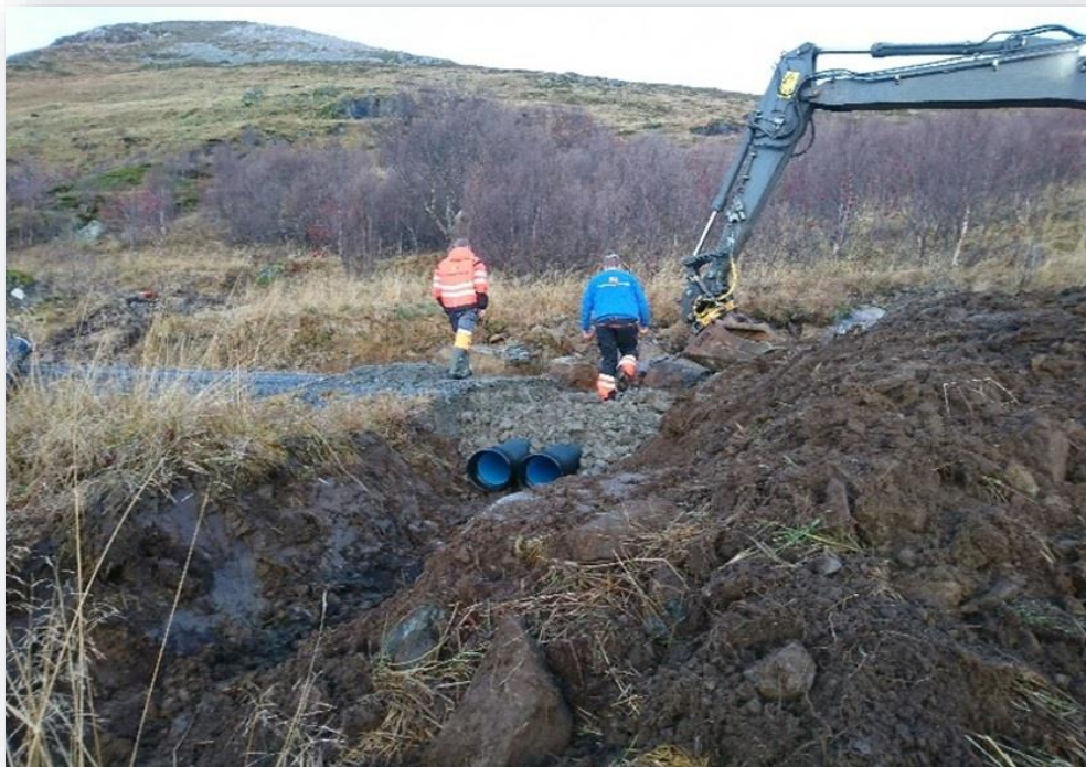
Figur 21 Bild av Hauan på Napp: ny grøft+ledninger
