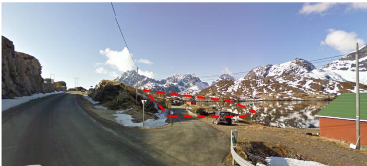
Figur 17: Tiltakets lokalisering i landskapet vist fra E10 nord for planområdet (uten etablert fylling)
