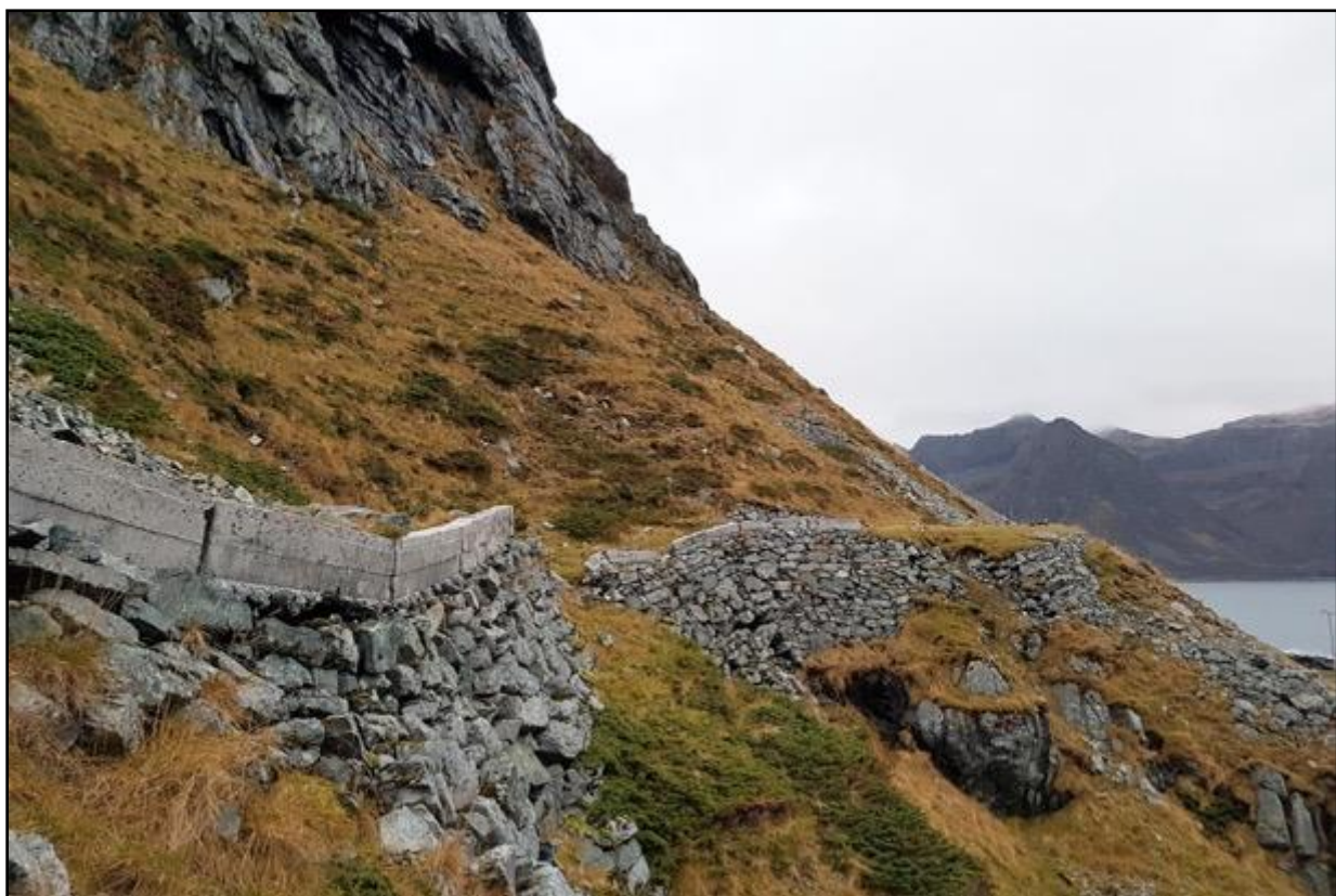
Gammelveien til Vikten: Påbegynt 1929, åpnet 1947, og erstattet av ny vei på 1970-tallet.
