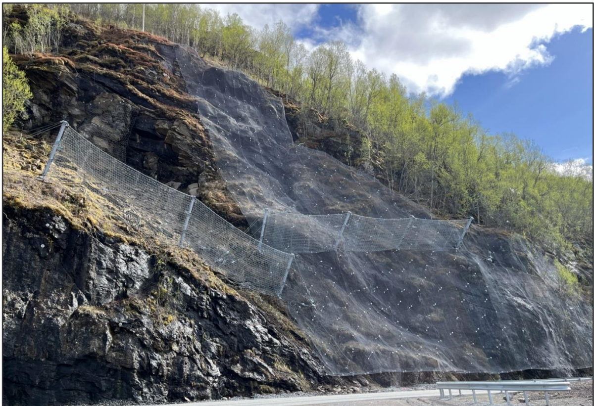
Figur 5-36. Eksempel på fanggjerd E6 Berrfloget (Statens vegvesen).
