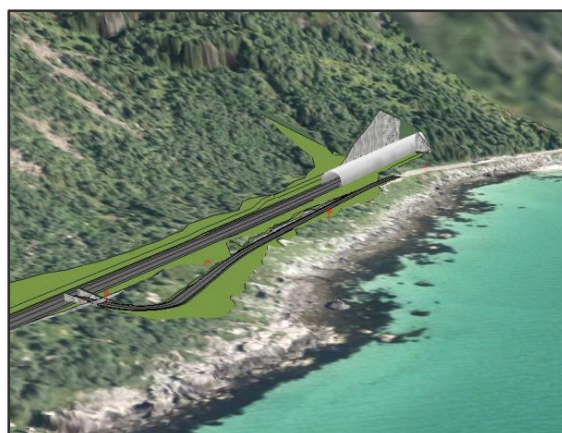
Figur 5-30. Blekkfjordtunnelen påhugg nord (Statens vegvesen).
