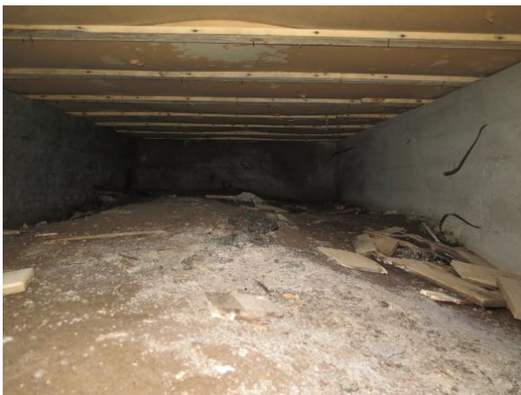
Foto 1. Krypekjeller under klasseromsfløy.
