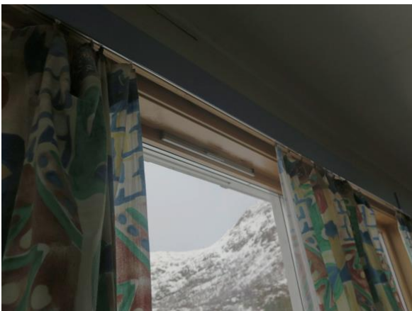
Foto 9. Spalteventiler over alle vinduer i klasserommene.
