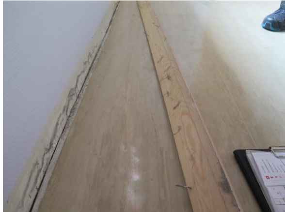
Foto 12. Gang utenfor klasserom. Bakside gulvlist. Ingen tegn til muggsoppvekst.
