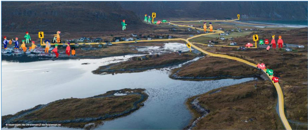
Fredvang-området - fra Fredvangbru: Fredvang havn til venstre, skoleplassen med stor parkering til høyre, og utsikt mot Indresand og Ytresand. Illustrasjon Ida Christensen, NODA-prosjektet.
