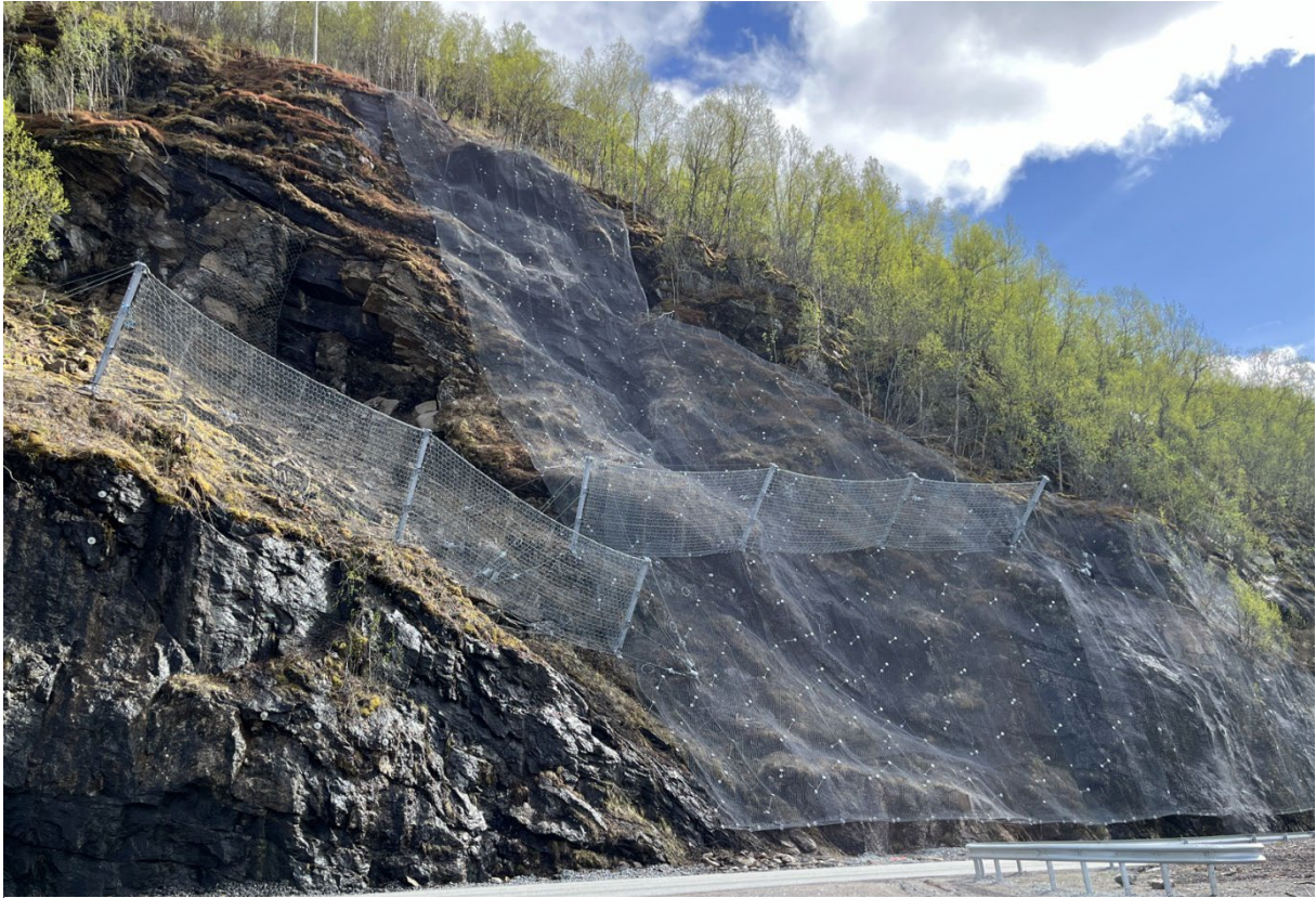
Figur 3-36. Eksempel på fanggjerd E6 Berrfloget (Statens vegvesen).
