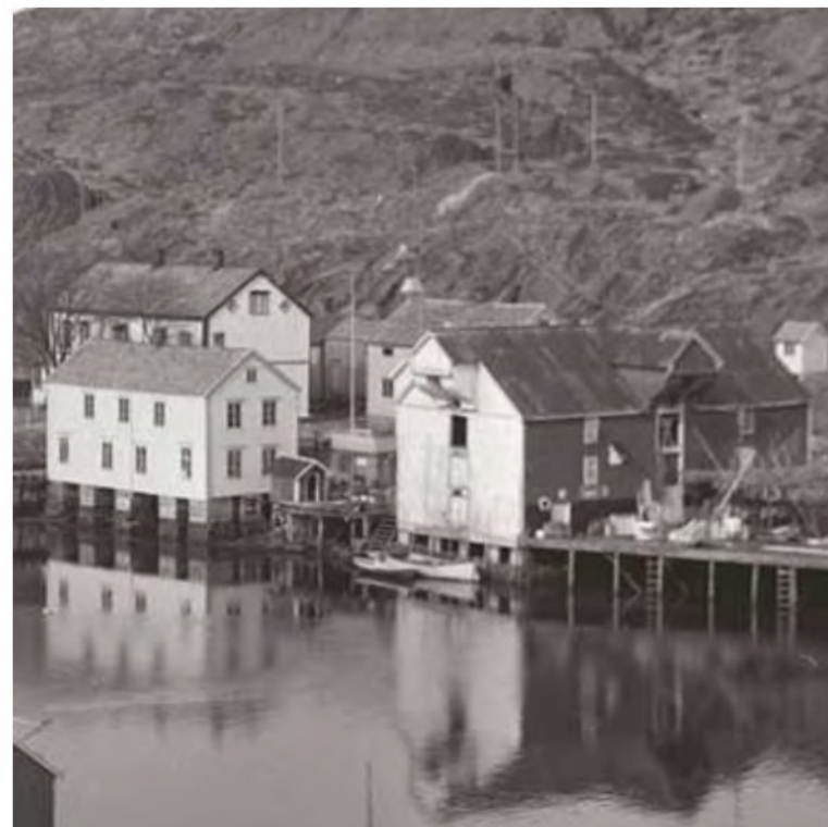
Det gamle sentrum, ulike fundamenter: pæler og betong
