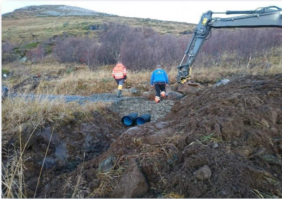
Figur 21 Bild av Hauan på Napp: ny grøft+ledninger
