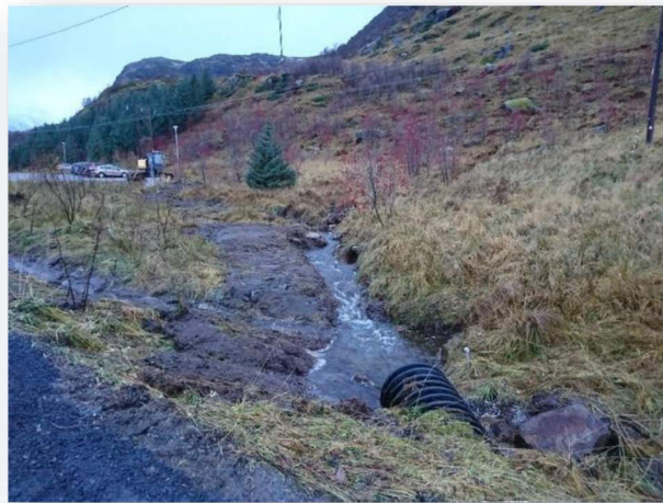
Figur 24 Bilde av Solhøydgeveien på Napp: utdypning av grøft
