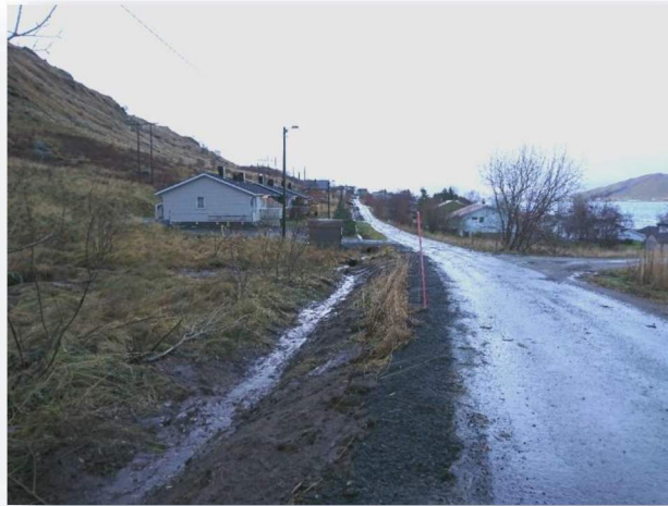
Figur23 Bilde av Solhøydgeveien på Napp: utdypning av grøfter
