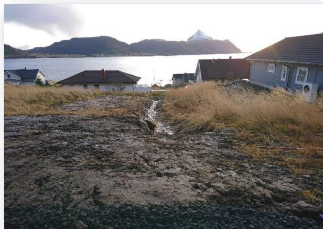
Figur 22 Bilde av Hauan på Napp: ny grøft
