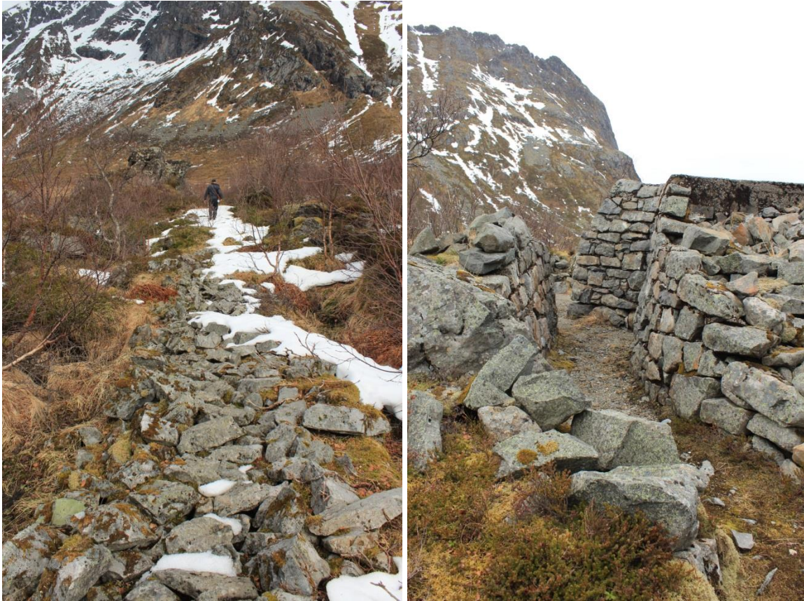
Figur 16 Fundament fjernet skinnegang i HKB Ramberg (venstre). Tørrmurt inngangsparti til flakstillingen i HKB Ramberg (høyre). Foto Gunhild Hovind.
