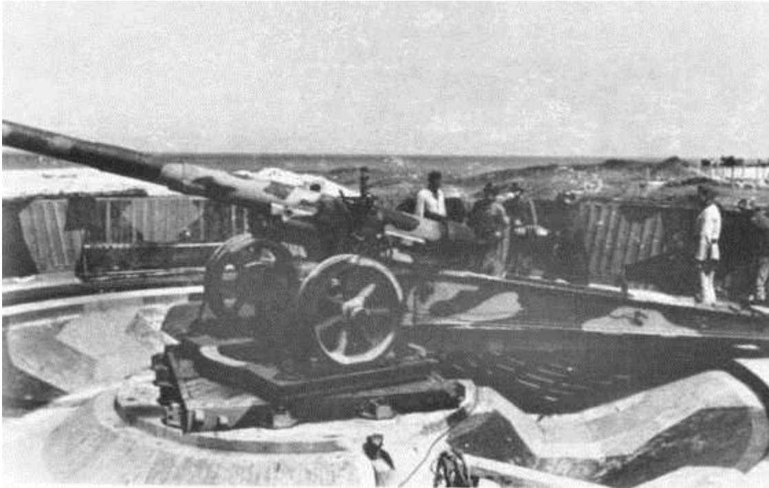
Figur 5 Kanon 15,5 cm K418(f) på dreieskive tilsvarende anlegg som er påbegynt på HKB Jusholmen. Bildet er hentet fra: http://lemairesoft.sytes.net:1945/weben/armes/artillerie/5454.html
