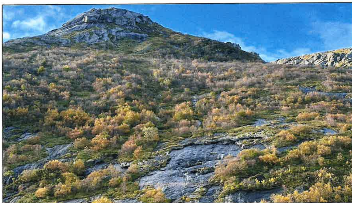
Figur 5: Bildet viser sva med eksfoliasjon, hvor flak midt i bildet mangler understøtte/fot. Til venstre i himmel sjå er det flere delvis avløste blokker, med størrelse opp mot 150 m 3 . Bildet er tatt mot nordvest.
