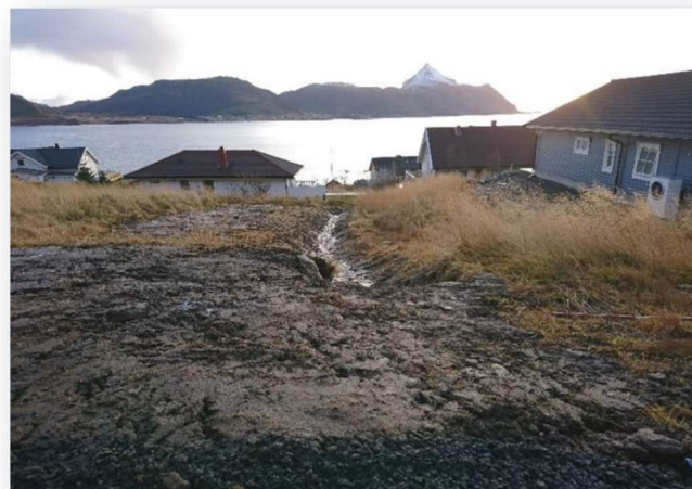
Figur 22 Bilde av Hauan på Napp: ny grøft
