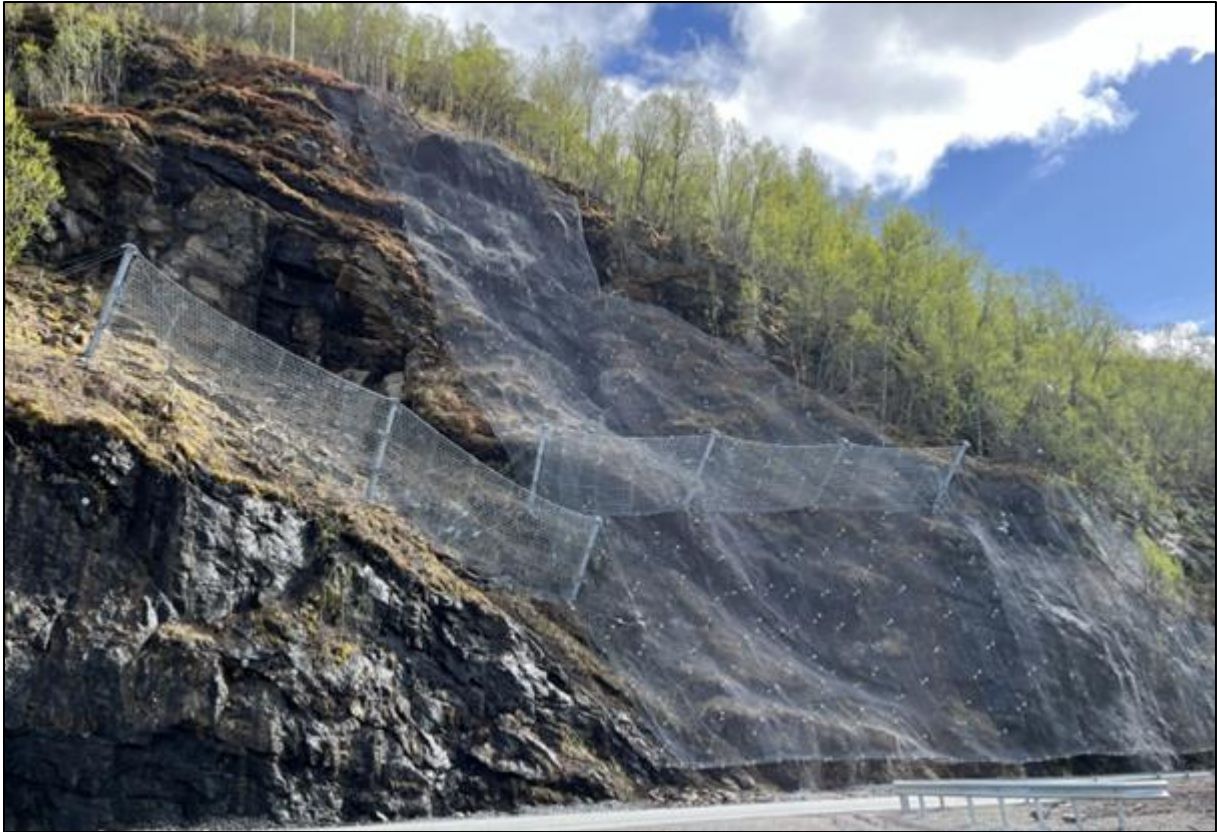
Figur 3-29: Eksempel på fanggjerd fra E6 Berrfloget i Sørfold (Statens vegvesen).
